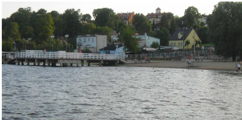
Fotografia nr 2. Nowa inwestycja Serocka – zagospodarowane nabrzeże miejskie wraz z molo, plażą, miejscami do cumowania itp. Źródło: Archiwum PART S.A.
