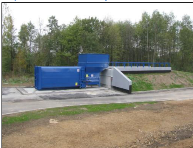
Stacja z wagą samochodową, zbiornikiem dezynfekcyjnym, budynkiem administracyjnym, rampą i prasokontenerem
