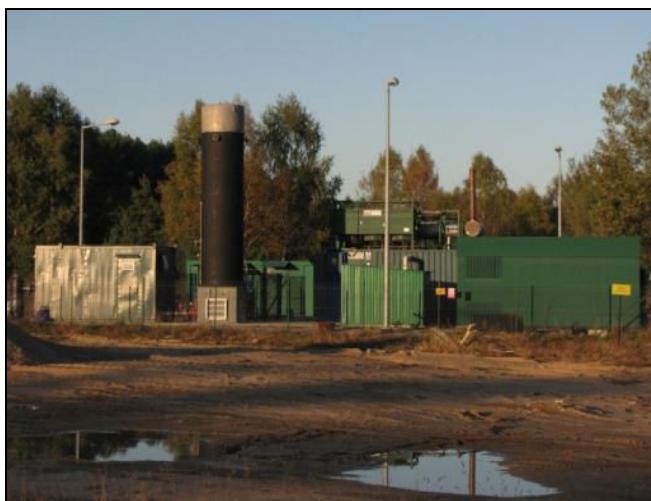
Z lewej system kompostowy KNEER, z prawej energetyczne wykorzystanie gazu składowiskowego
