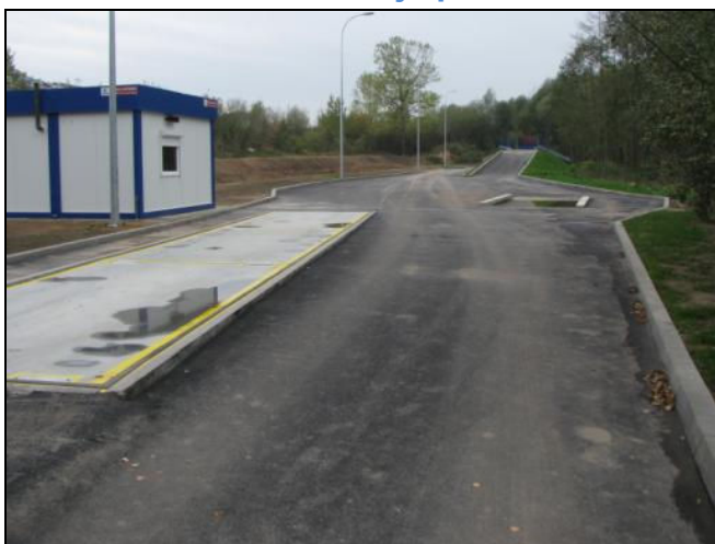
Stacja z wagą samochodową, zbiornikiem dezynfekcyjnym, budynkiem administracyjnym, rampą i prasokontenerem
