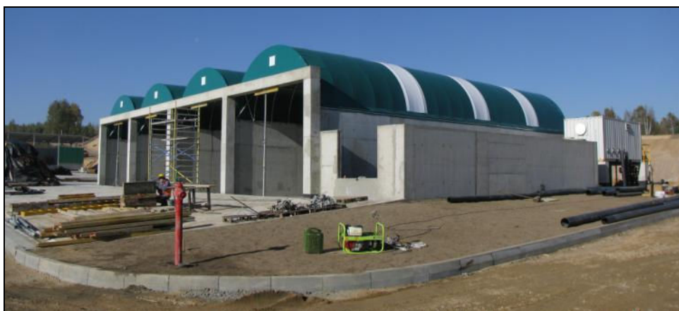
Budowana instalacja stabilizacji tlenowej (Compobox)
