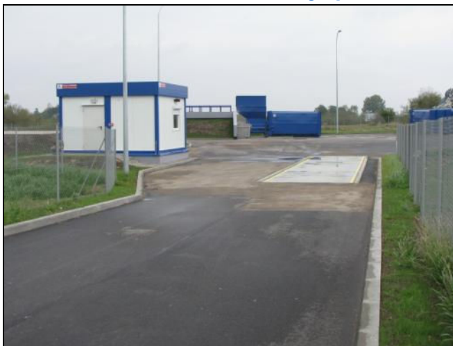
Wjazd na teren stacji, budynek administracyjny, waga samochodowa, zbiornik na odcieki, rampa, prasokontener
