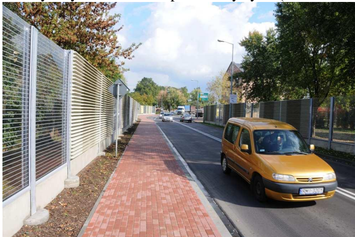
Rysunek 16. Dyfraktor zamontowany na krawędzi górnej ekranu akustycznego (źródło www.techbud.com.pl )
